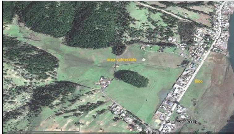
Figura N°4: Sector vulnerable adyacente al Estero Llico.
